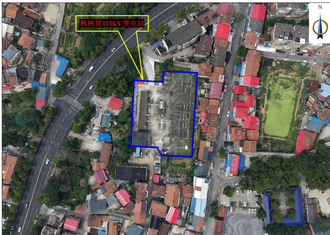
图 3-3 岳阳枫树坡 110kV 变电站周围环境现状
