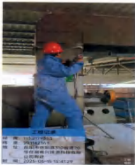
DA002 干燥废气排放口
