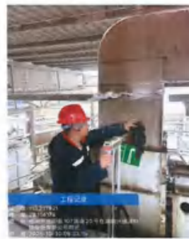
DA002 干燥废气排放口
