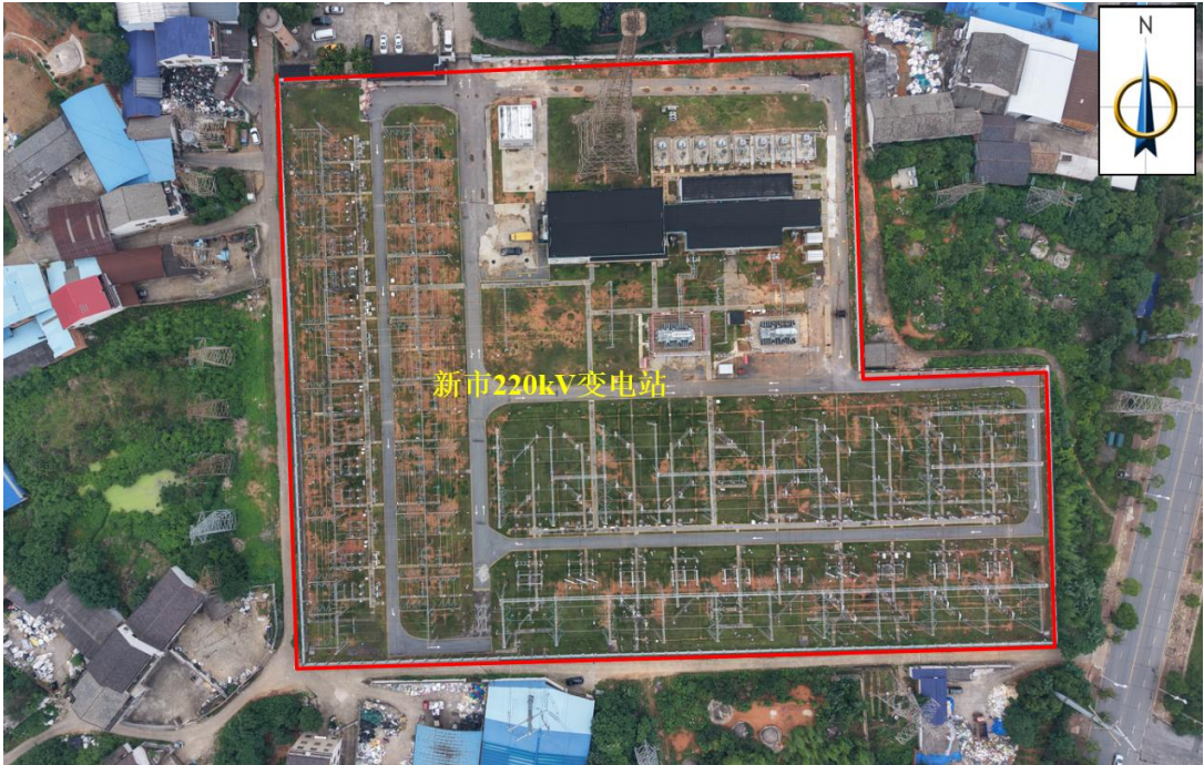
图 3-3 新市 220kV 变电站周围环境现状
