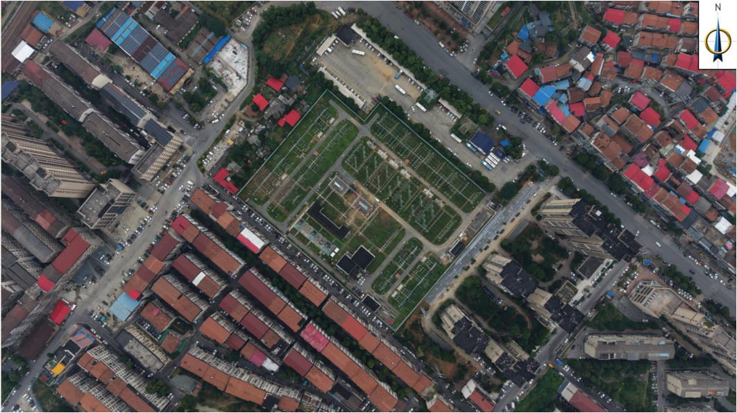
图 3-3 岳阳洛王 220kV 变电站周围环境现状
