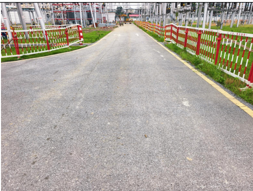
站内道路硬化
