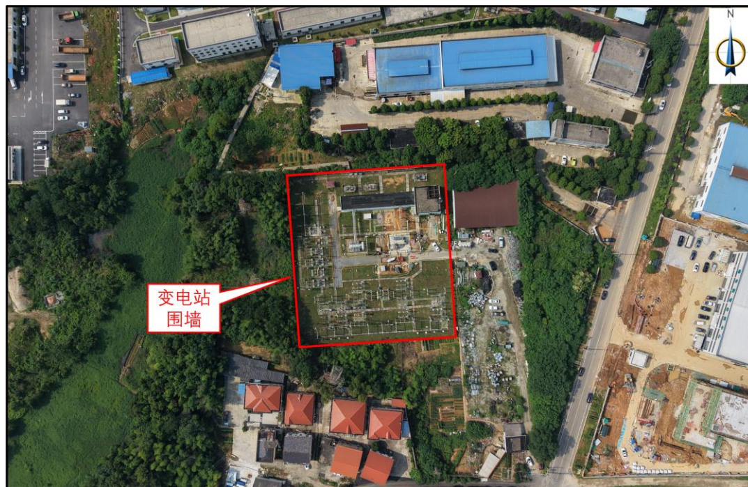
图 3-3 窑洲 110kV 变电站周围环境现状
