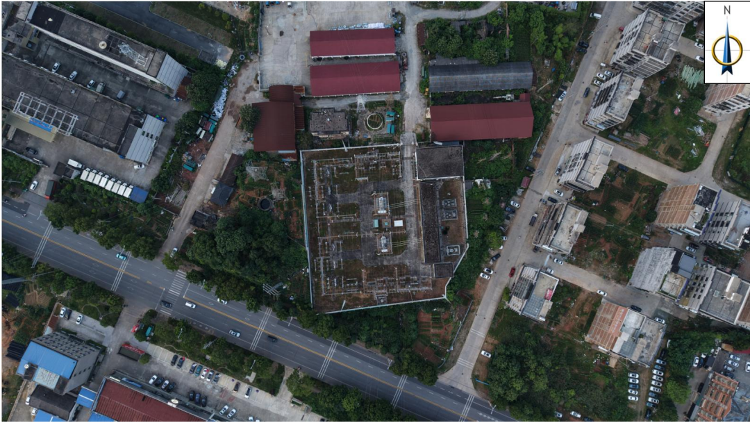
图 3-3 岳阳平江 110kV 变电站周围环境现状
