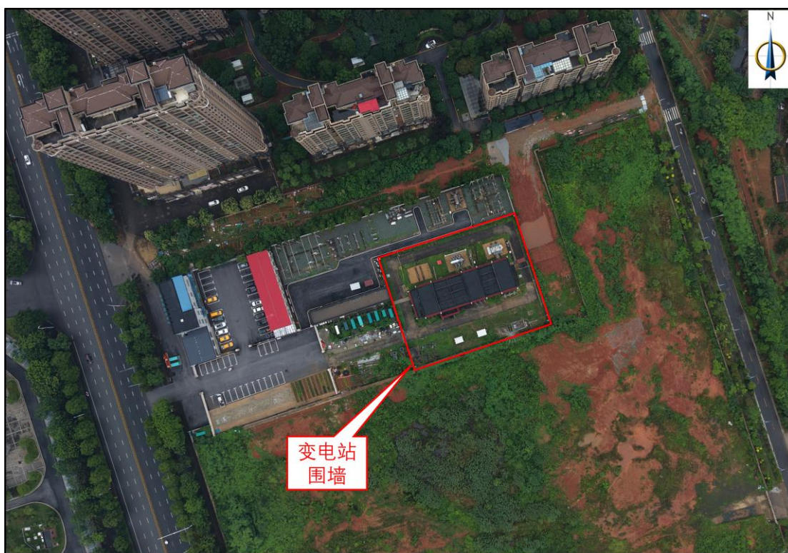
图 3-3 湖滨 110kV 变电站周围环境现状
