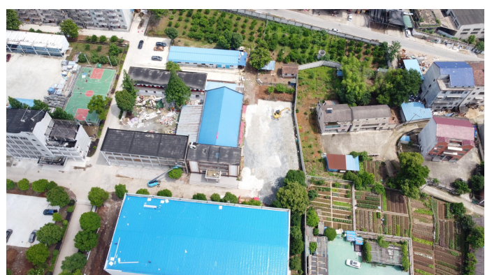
铅房拟安装地北侧预制车间
