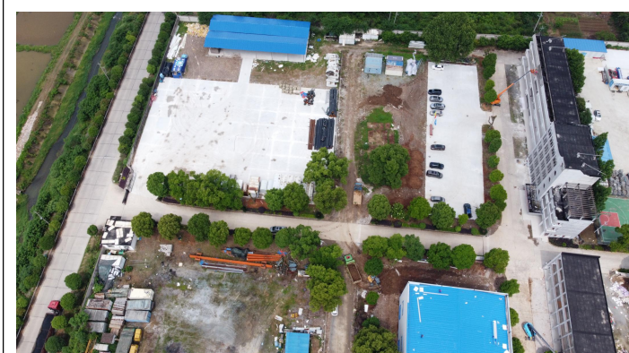
铅房拟安装地西侧道路
