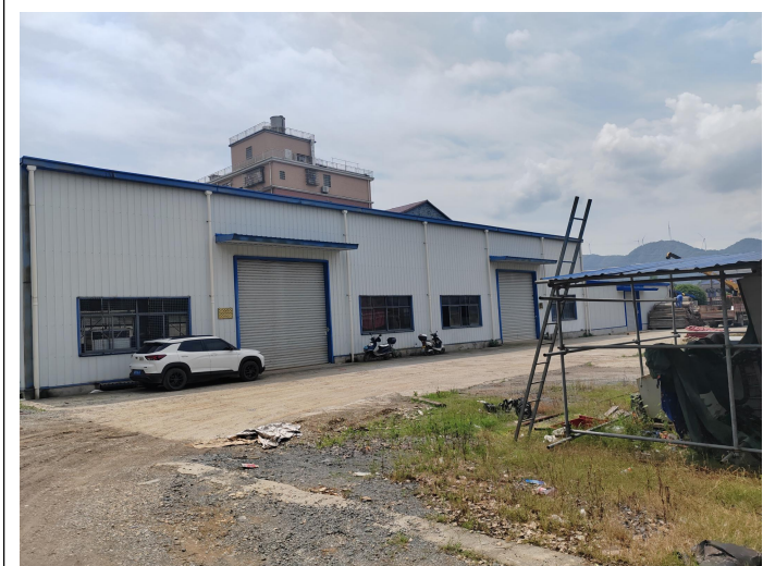
铅房拟安装地南侧加工车间
