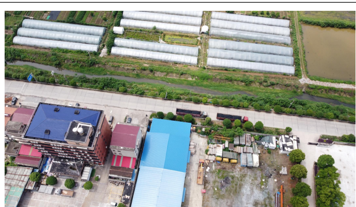
铅房拟安装地南侧加工车间
