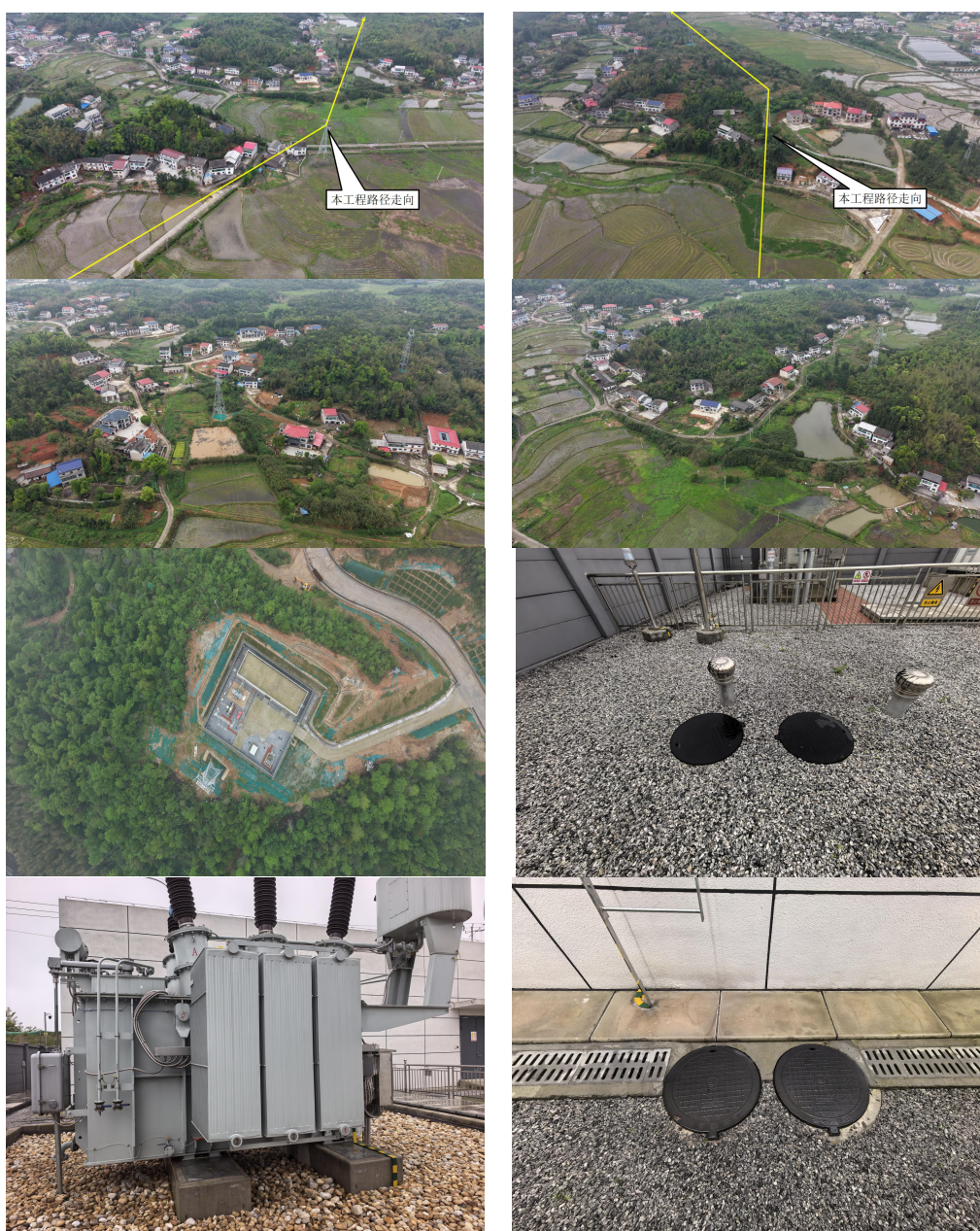
图 3-3 变电站及输电线路生态环境现状
