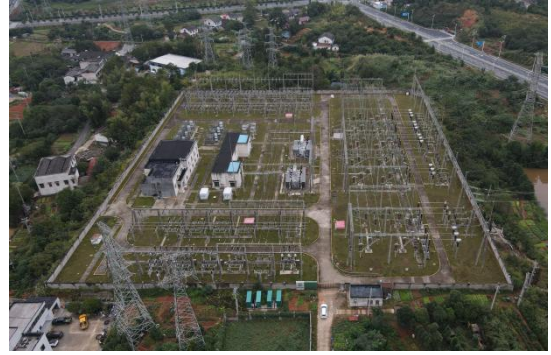
汉昌220kV变电站站址环境现状
