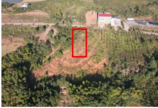
献冲110kV变电站站址环境现状
