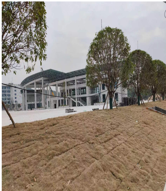
学院内部（建设中）
