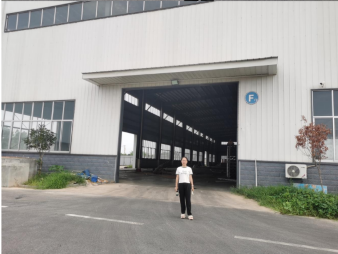
工程师现场踏勘照片
