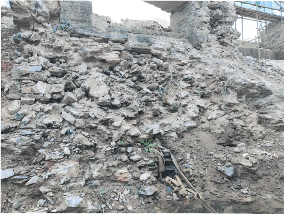
青冲水闸大坝原来浆砌石坝体内部结构情况
