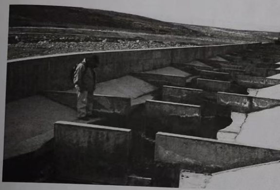
青冲水轮泵电站鱼道示意图
