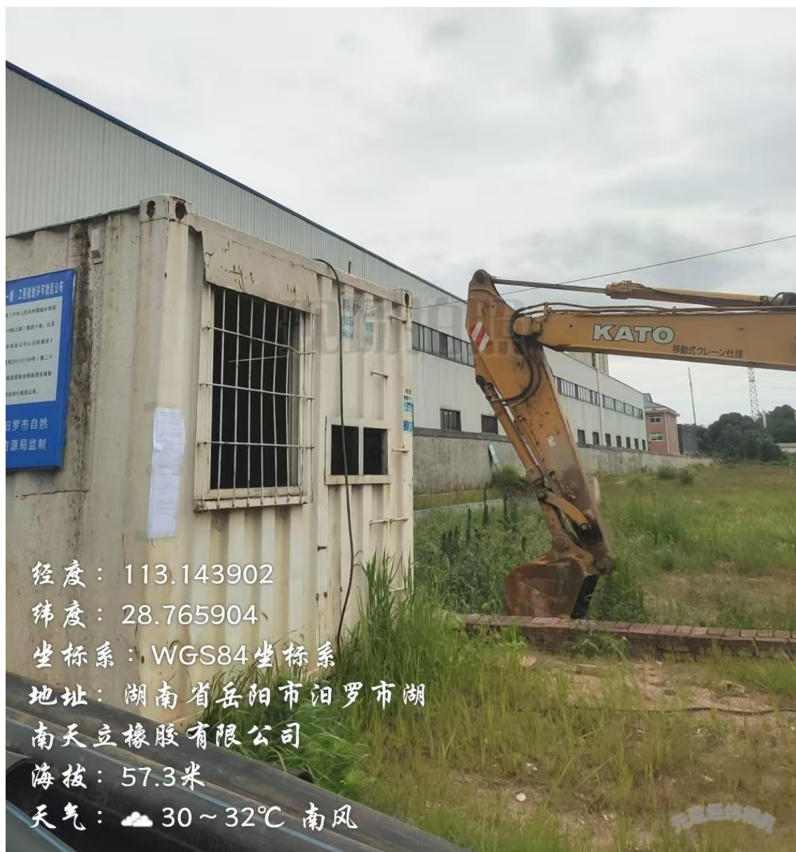
图4 二次新厂区现场张贴公示
