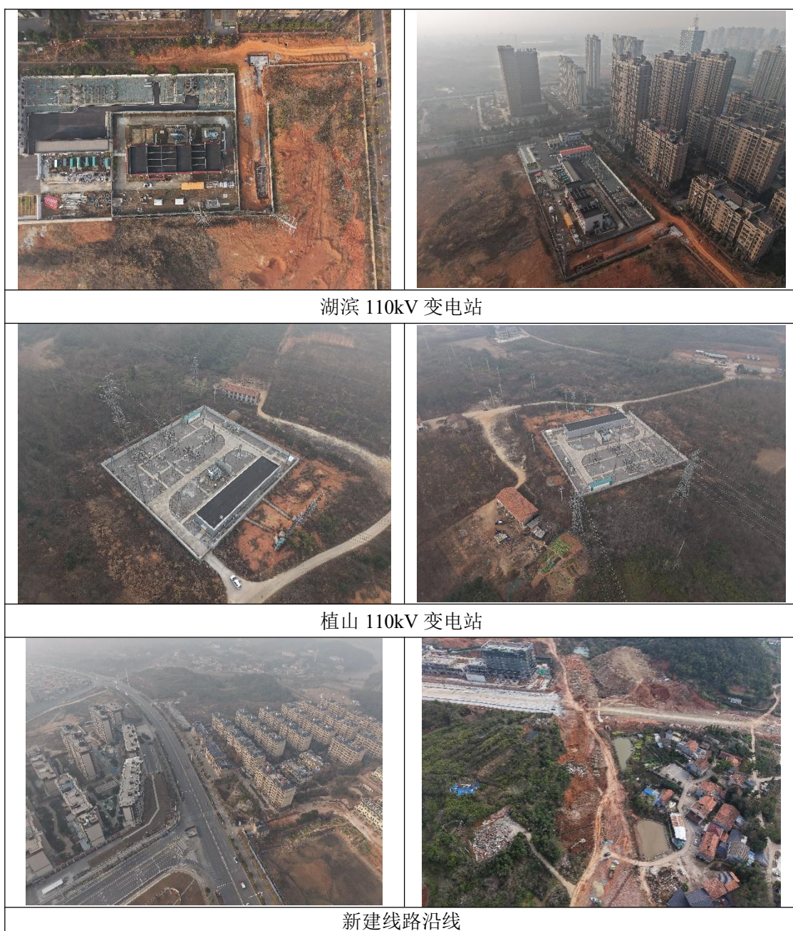
图 6 本工程环境现状
