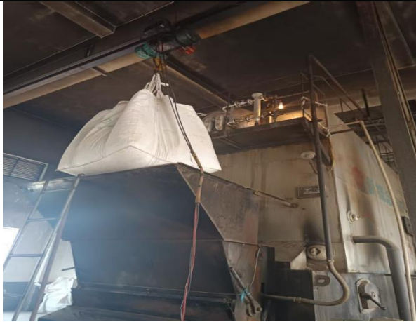
成型生物质燃料燃料投料方式
