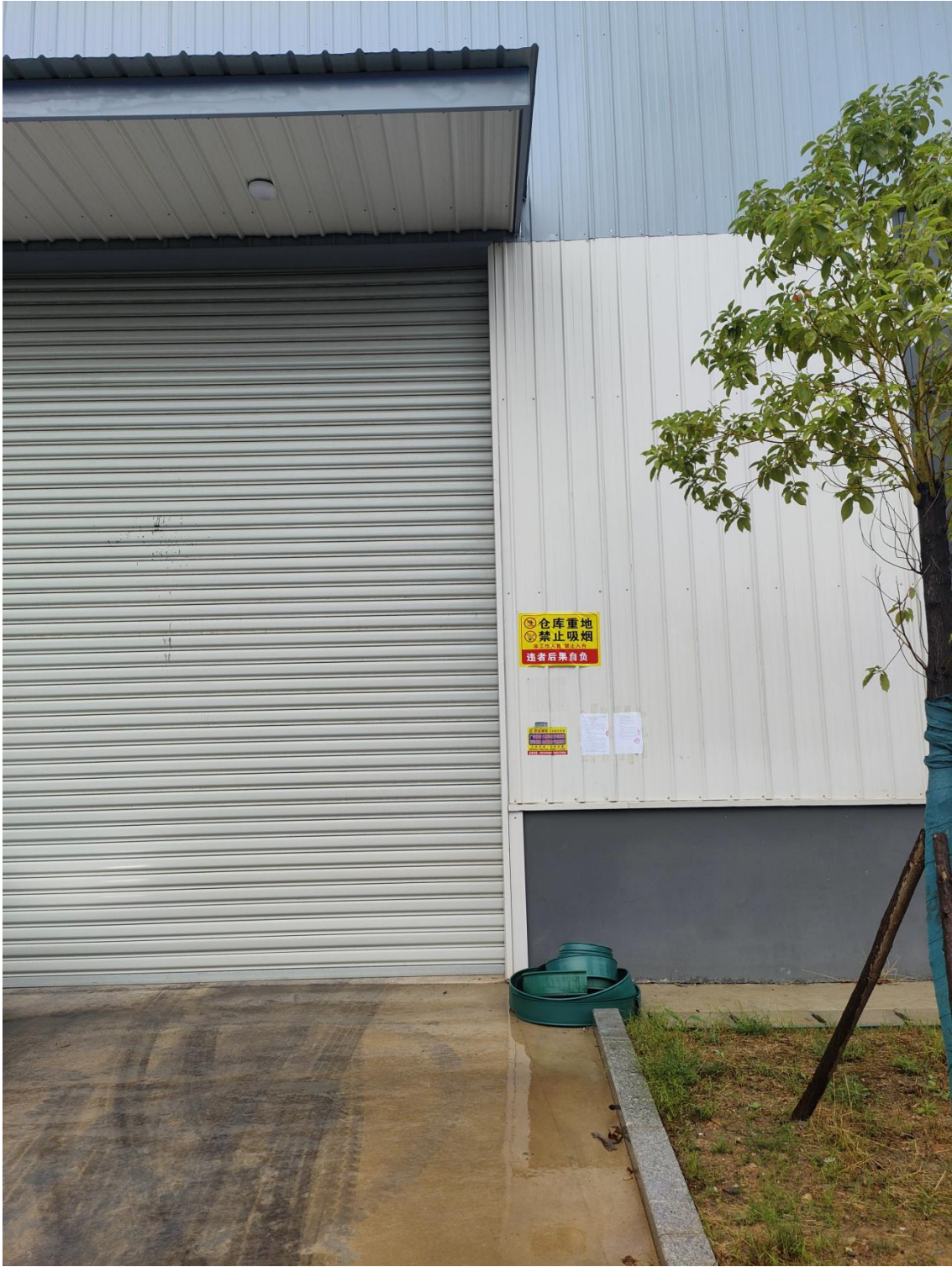
图 3 二次现场张贴公示
