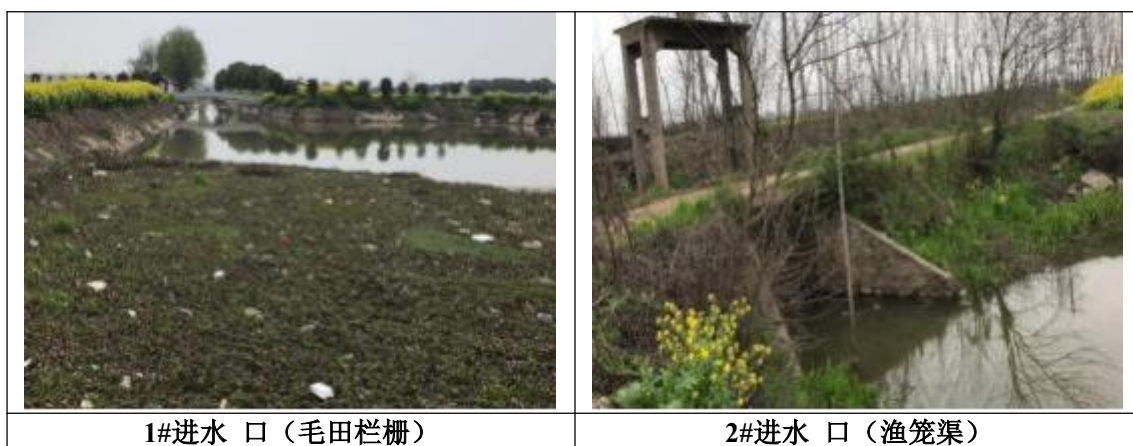
图 3.1-4 1#进水口（毛田栏栅）和 2#进水口（渔笼渠）现状图
