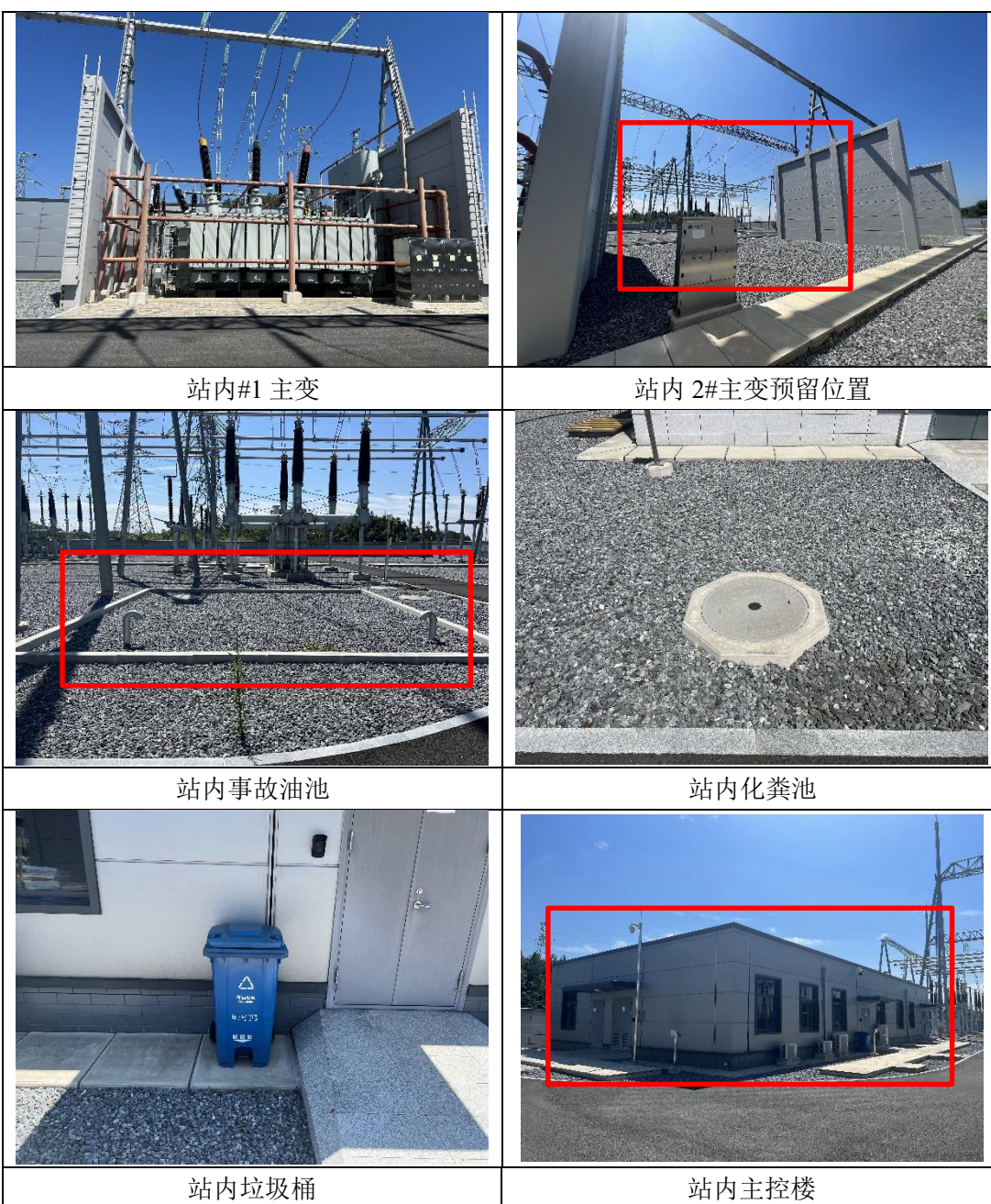
图 1 画桥 220kV 变电站站内环境现状
