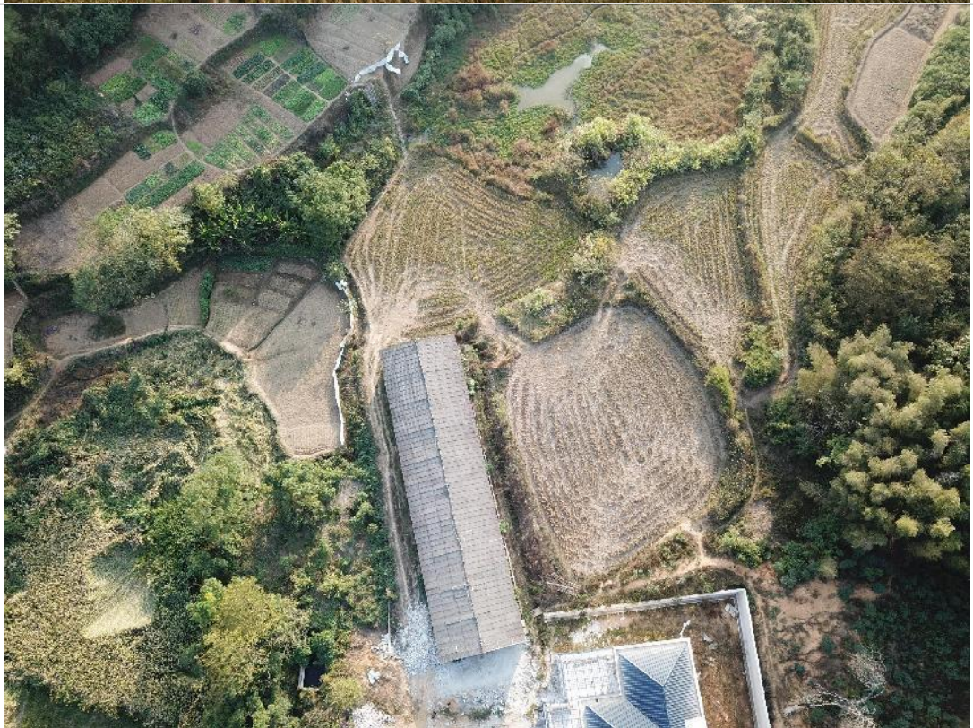
110kV 架空线路工程沿线环境现状
