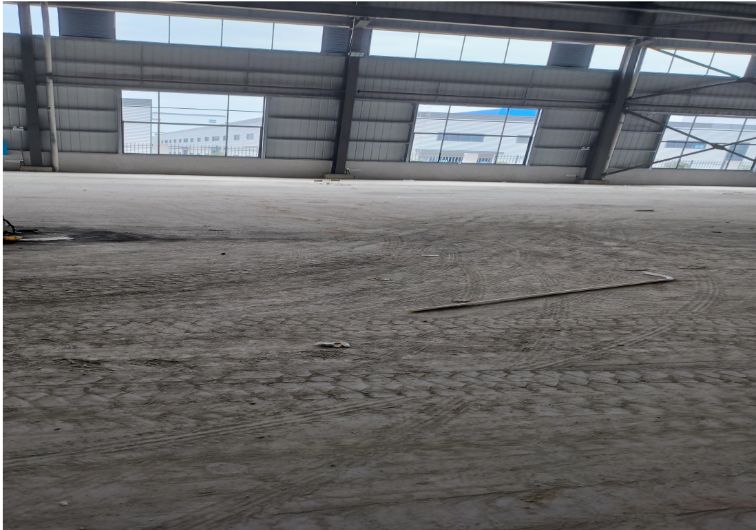
图 6.5-1 本项目生产厂房内现状照片
