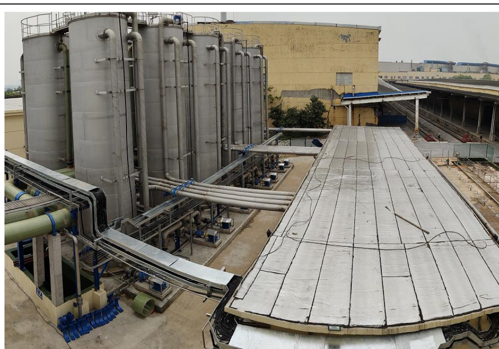
在建污水深度处理系统（芬顿+砂滤）正在通水调试阶段
