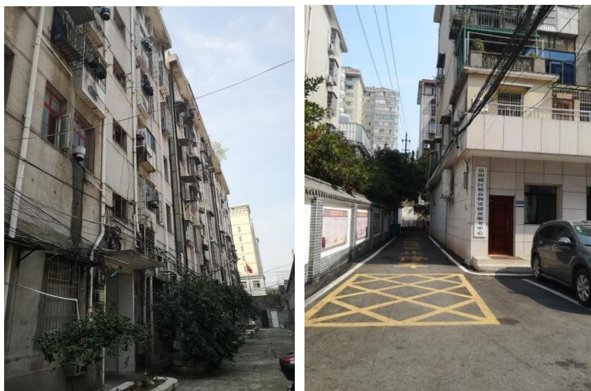
岳阳楼区粮食局现场图
