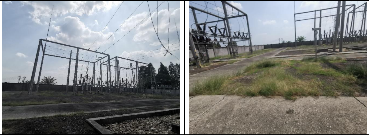
站内地面硬化和绿化
