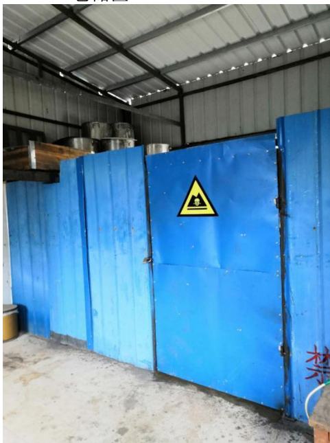
危险固废暂存间
