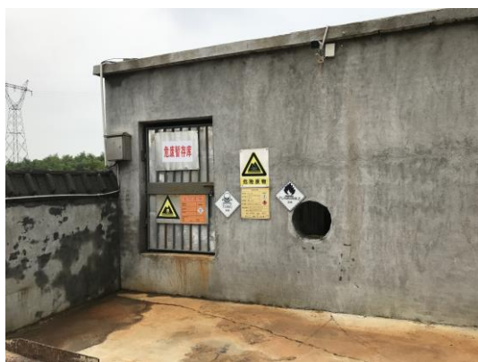
危险废物暂存间
