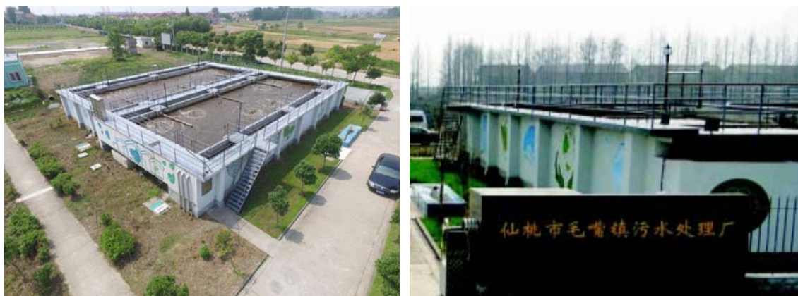
图 8 仙桃市毛嘴镇污水处理厂厂区图
