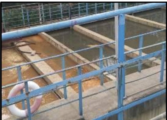
化肥污水处理装置斜板沉淀池
