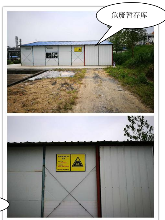
图 3.16 危废暂存库及标识
