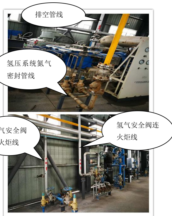
图 3.10 氢压机氮气密封和氢气安全阀连火炬
