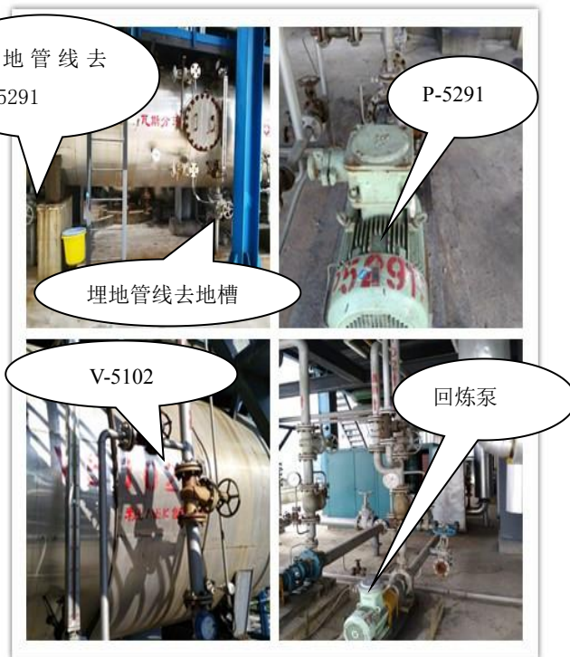
图 3.14 瓦斯分液罐地下管线和回炼泵图
