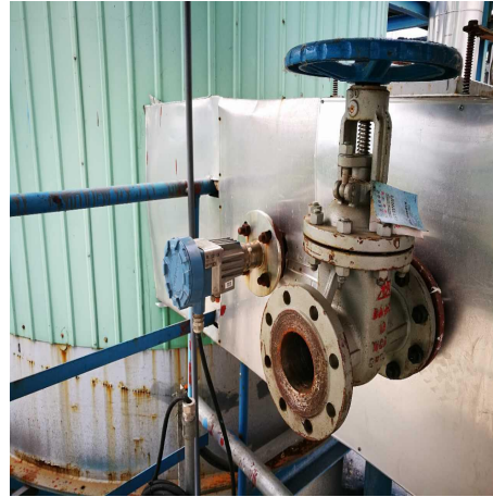
导热油炉烟道采样口
