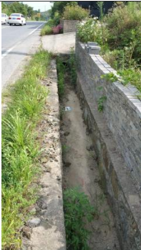
公路两侧排水设施（明沟）
