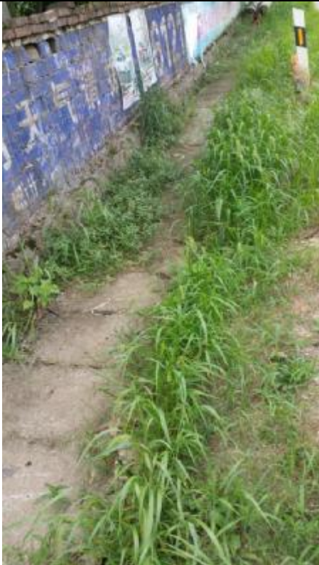
公路两侧排水设施（暗沟）
