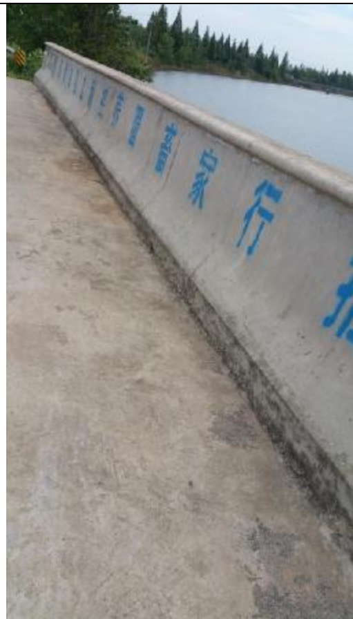
桥梁两侧防撞防护
