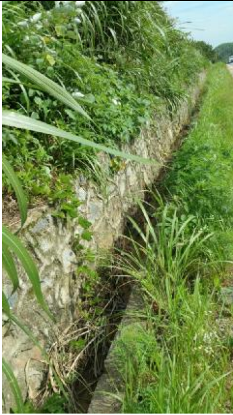
公路两侧边坡防护及排水设施
