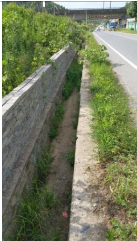
公路两侧排水设施（明沟）
