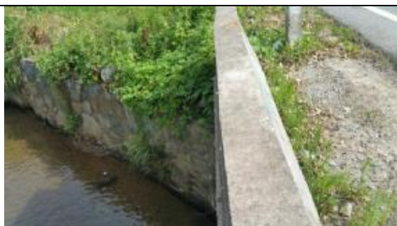
桥梁两端边坡防护
