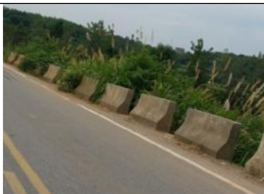
临水路段路侧防护
