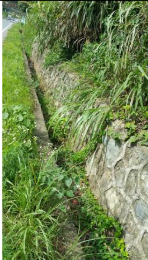
公路两侧边坡防护及排水设施
