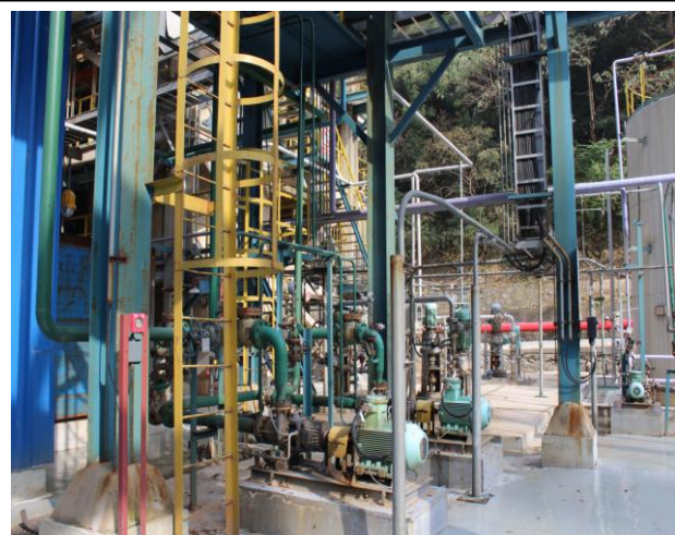
新建脱硫废水处理单元
