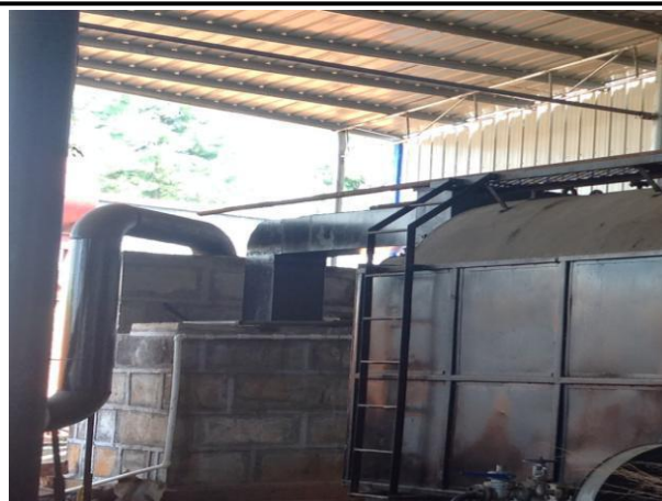
麻石水膜除尘器
