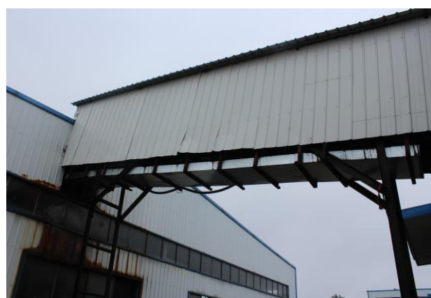
传送带过道（下方已安装收集槽）
