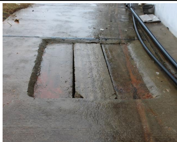
地埋式化粪池
