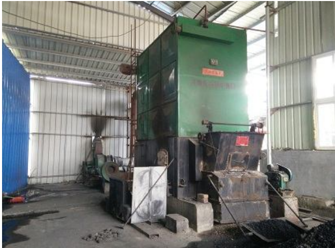
(12#) 2T 燃煤导热油炉
