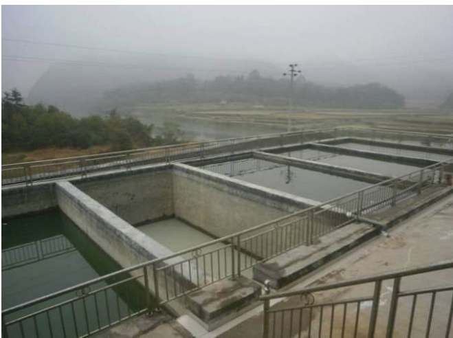
初期雨水收集池及沉淀池
