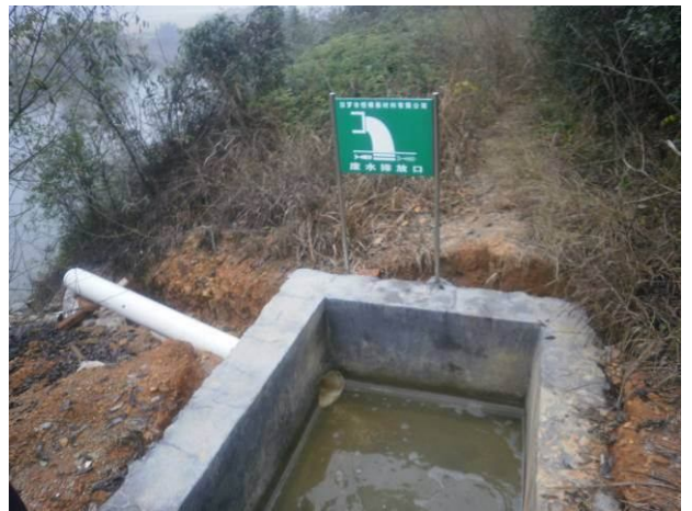
废水处理设施外排口
