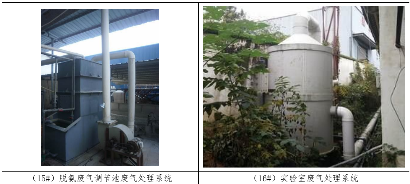
图 4-7 废气处理设施图（四）
