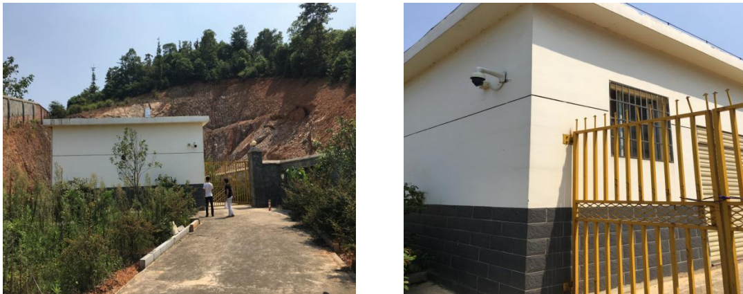
图4 新开泵站污染源监测现场
