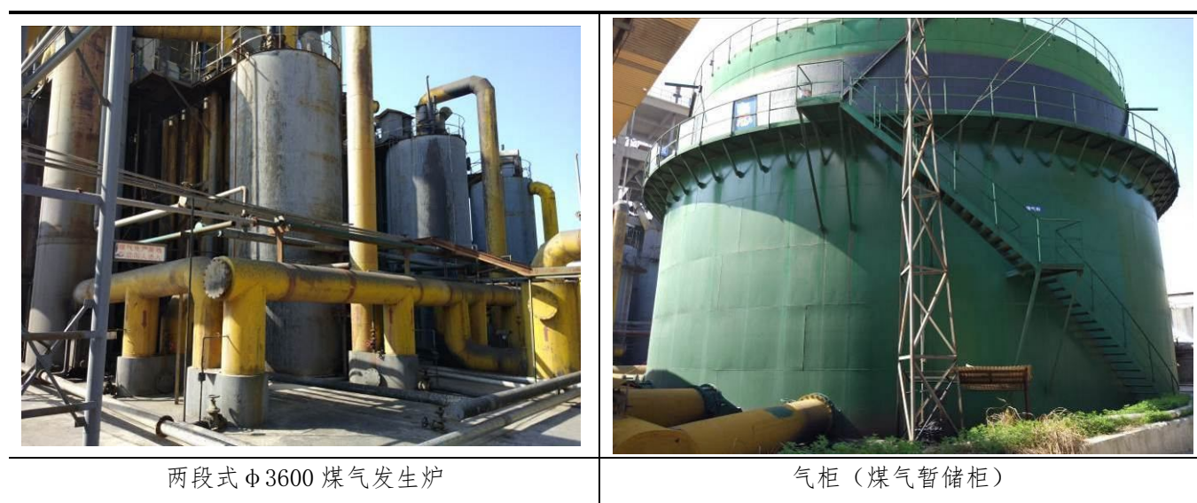
图 3-5 煤气站示意图
