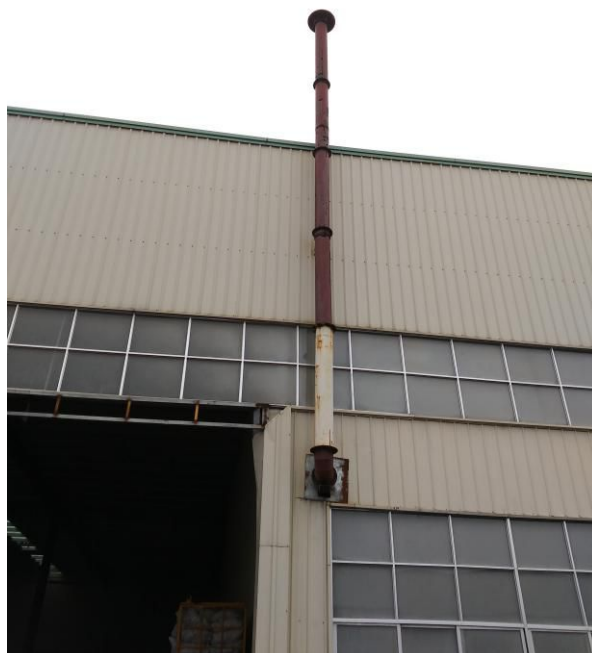
锥玻璃（含铅）破碎线排气筒
