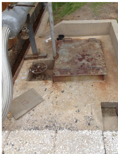
乙酸装卸罐区收集池
