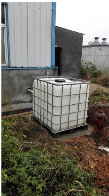
硫酸储罐应急设施
