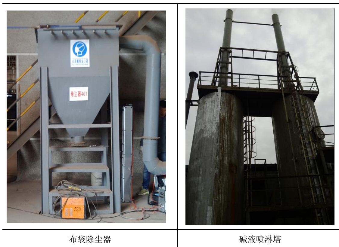
图 3-6 废气处理设施图
