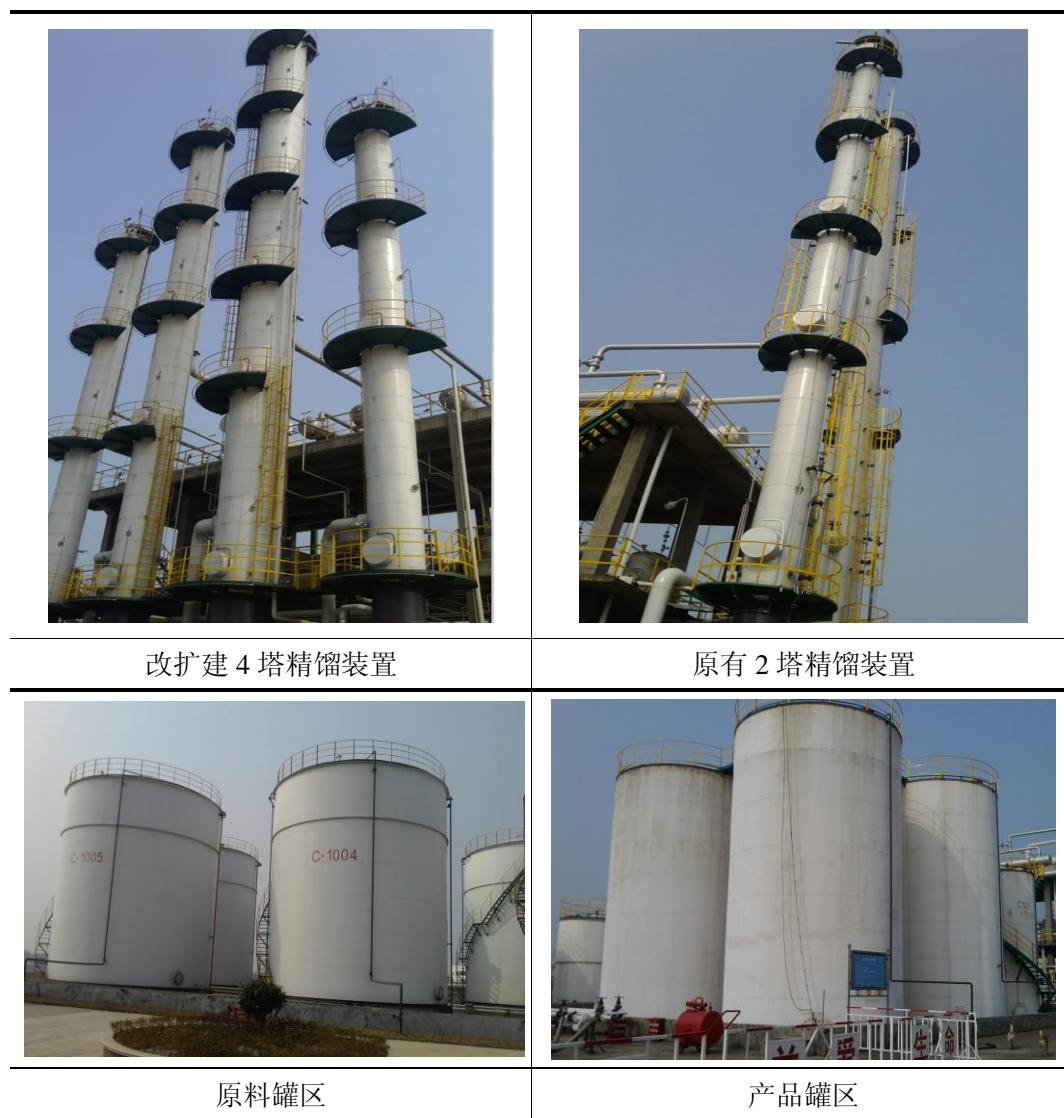
图3-4 生产设备、罐区
