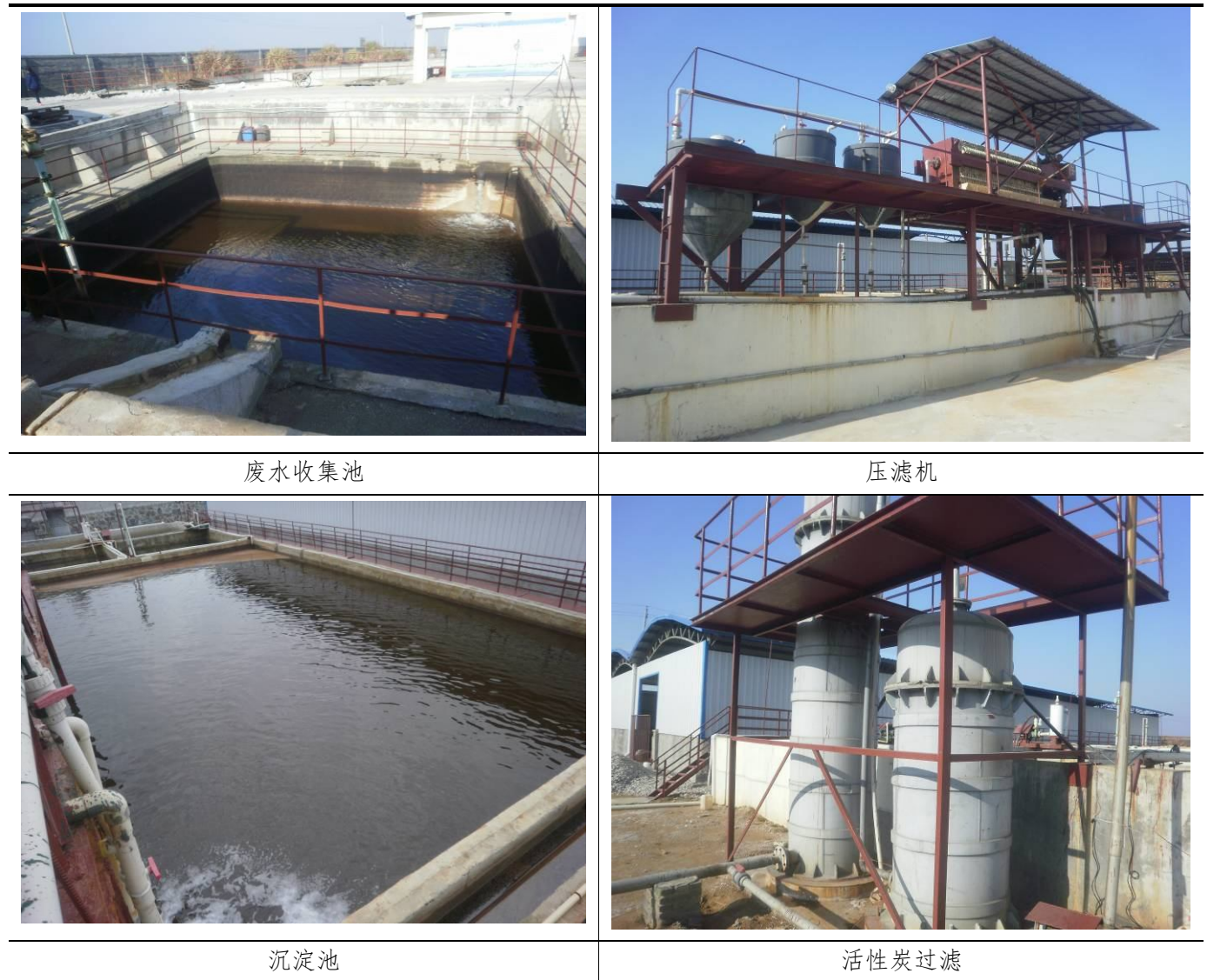
图 3-10 废水处理装置示意图
