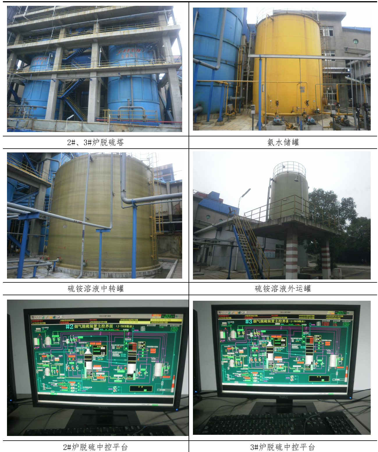
图 3-5 锅炉废气脱硫处理设施示意图
